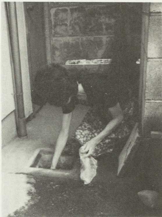
ふろや台所から出た所にあるマスは油や異物が詰まりやすいのでふたを開けて清掃してください。
